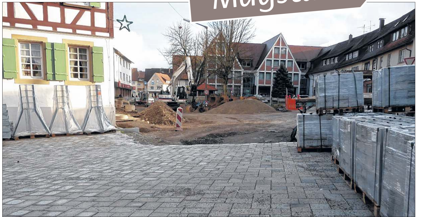
Mit diesen Steinen werden Wege, Straßen und Plätze im Magstadter Ortskern verlegt. Anfang Dezember war das Pflaster in der Planstraße bereits so gut wie fertig. Bild: Reichert
