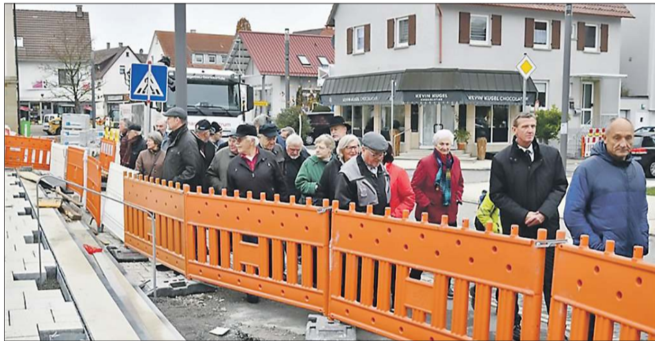
Die Nufringer begutachteten die Bauarbeiten in der Ortsmitte.
